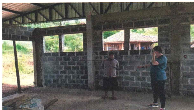
Figura 5: Construção da Agroindústria da comunidade.
